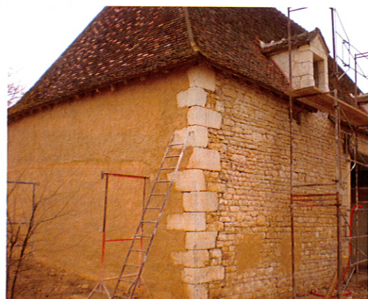
État sanitaire avant restauration : fissures et bombement du mur latéral.
