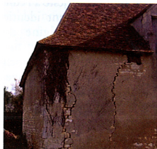
État sanitaire avant restauration : fissures et bombement du mur latéral.
